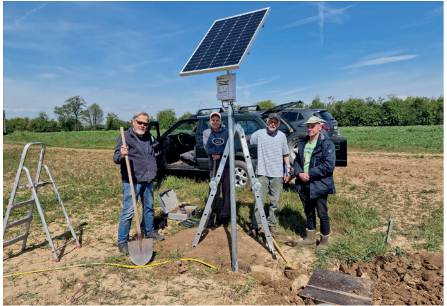
Aktive von BUND und NABU beim Installieren der Solarpumpe
